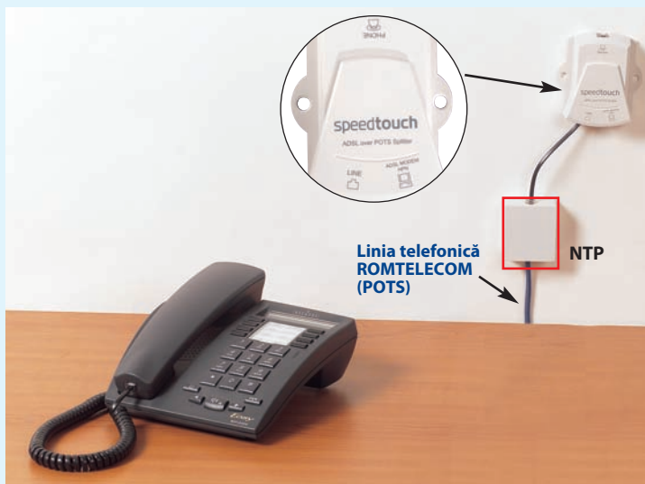
Figura 9: Splitter-ul este conectat la NTP.
